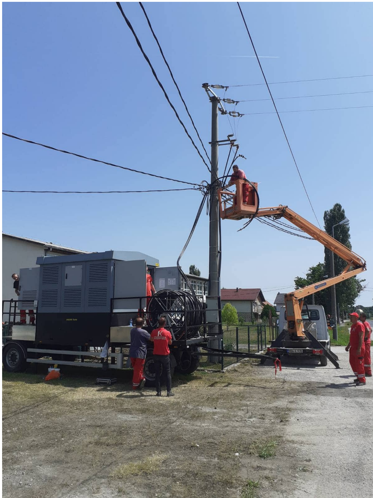
Ove mobilne trafostanice pogodne su i kao privremeni priključci za industrijska postrojenja, koja čekaju izgradnju vlastitih
